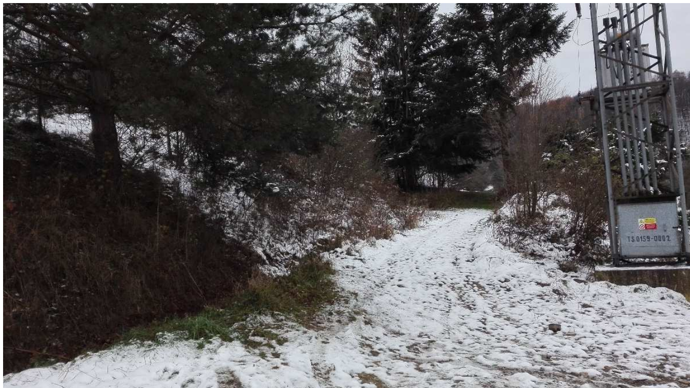
Obrázok č. 39 – existujúca hlavná poľná cesta rP-18 určená na revitalizáciu – napájajúca sa na miestnu komunikáciu v intraviláne, po pravej strane prvý transformátor na stožiar
