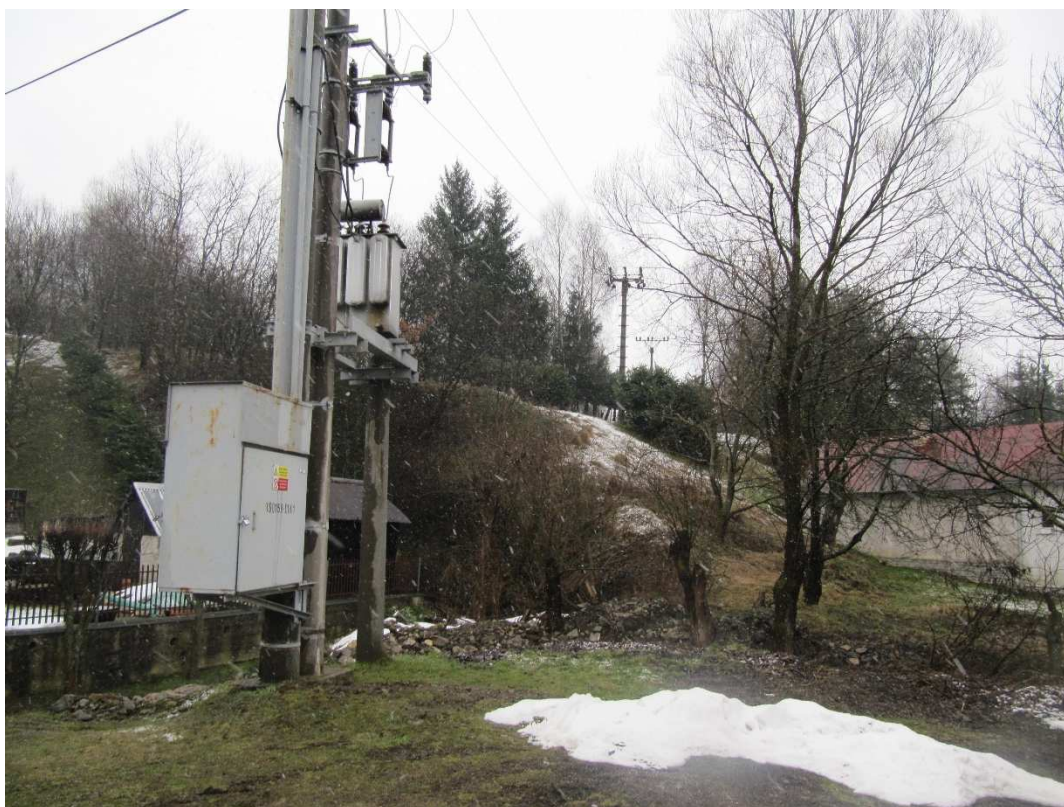
Obrázok č. 32 – Transformátorová stanica – v strede obce Ňagov
